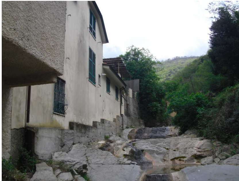
Foto 12: Finestre fronte alveo (sez.135-150)
