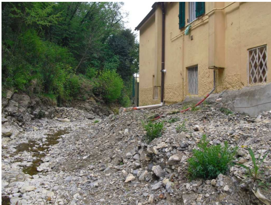
Foto 14: Accumulo di materiale a ridosso del civico 23A (sez.190)
