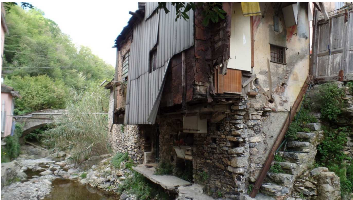
Foto 5: Fabbricato pericolante con superfetazione a sbalzo (sez.13-20)
