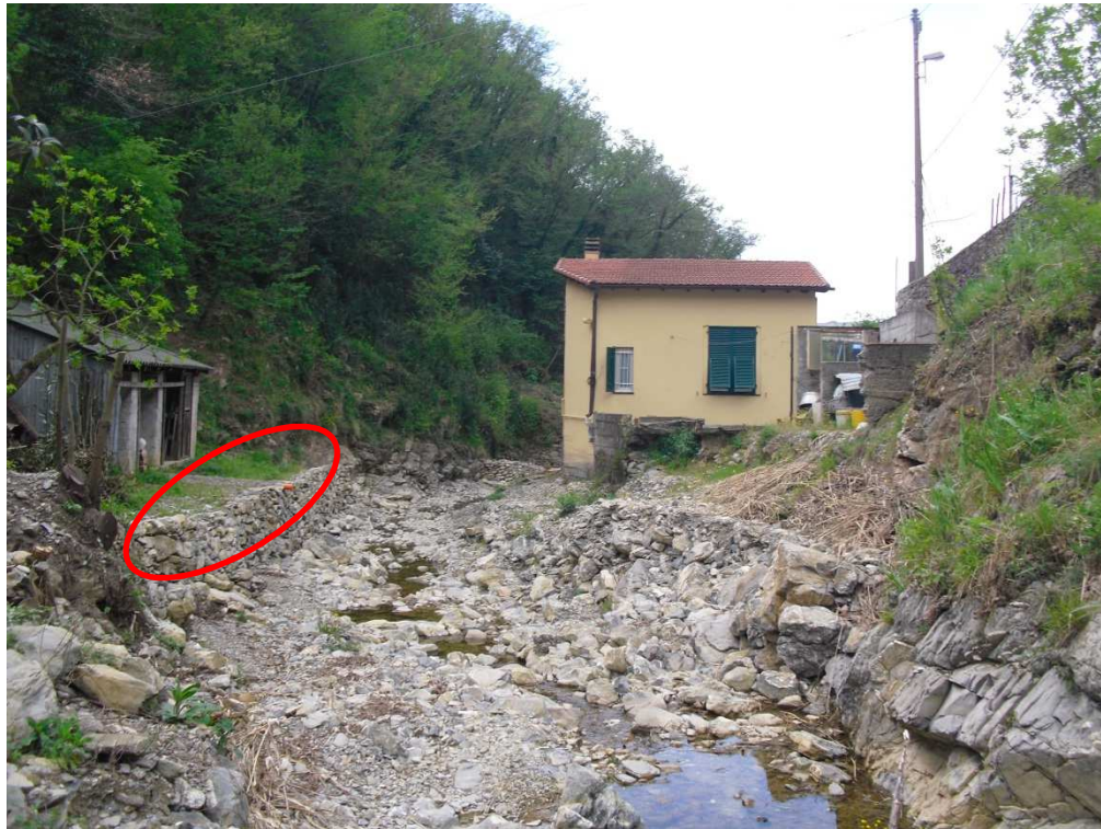
Foto 17: Area soggetta ad allagamento in caso di passaggio della portata di piena 200ennale e in condizioni di briglia ostruita
