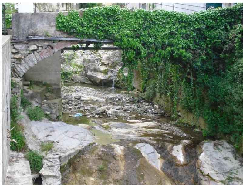
Foto 4: Tubazioni aggraffate al ponte di monte
