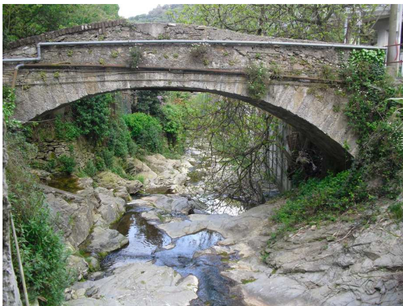
Foto 3: Tubazioni aggraffate al ponte di valle
