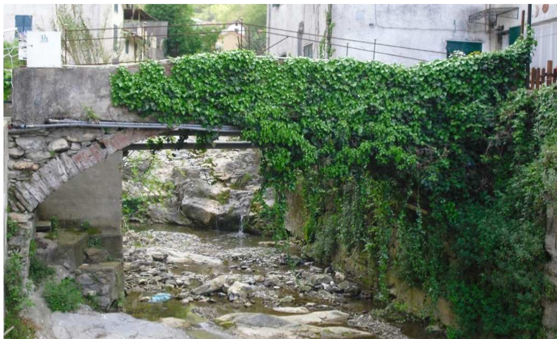
Foto 11: Ingombro del fabbricato a monte del ponte ad arco
