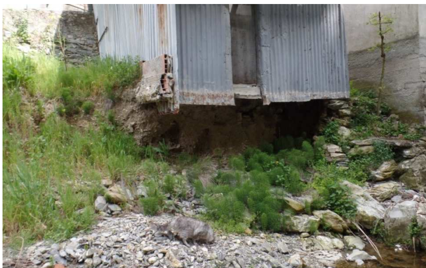
Foto 9: Baracca con terrapieno eroso (sez.55-60)
