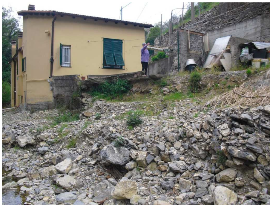
Foto 15: Cortile di monte e manufatti del civico 23A (sez.195-200)
